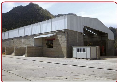
อาคารโรงงาน
